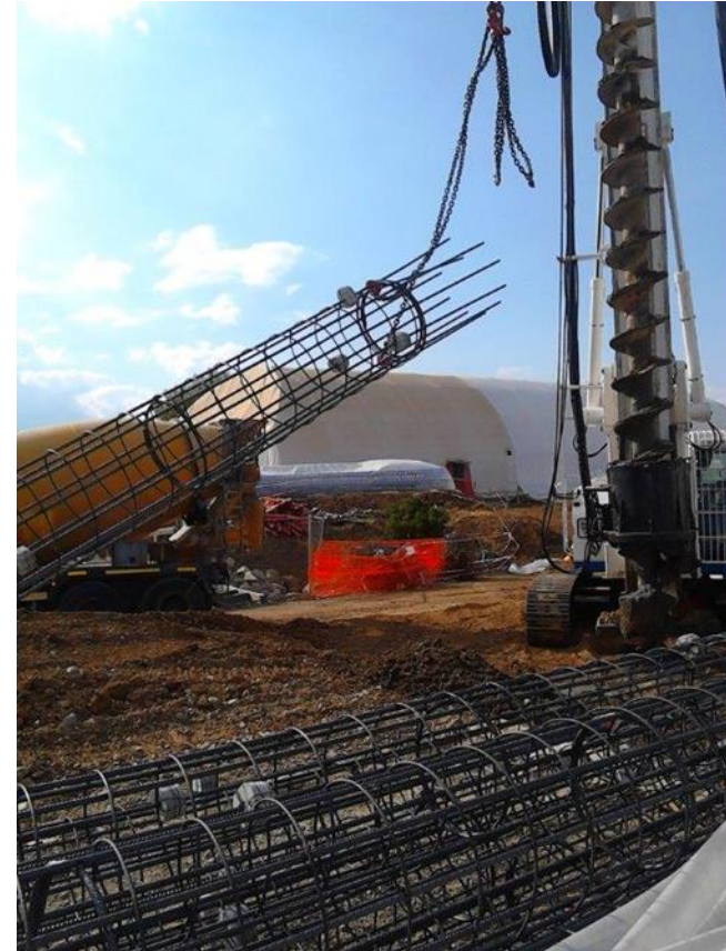
Installazione palificata di sostegno
